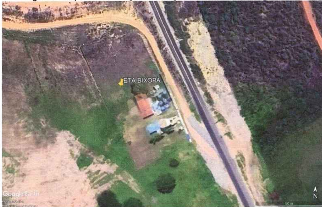
Figura 1 - Mapa de Localização da Estação de Tratamento de Água – ETA
